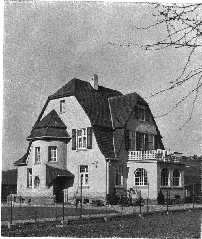
Eingangsfassade des Wohnhauses (Grundriß S. 74)
