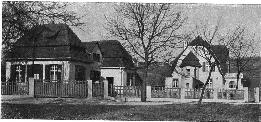
Ansicht der ganzen Anlage
