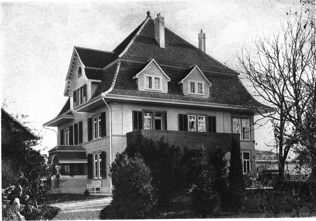
Die StraÙenfassade nach dem Umbau
