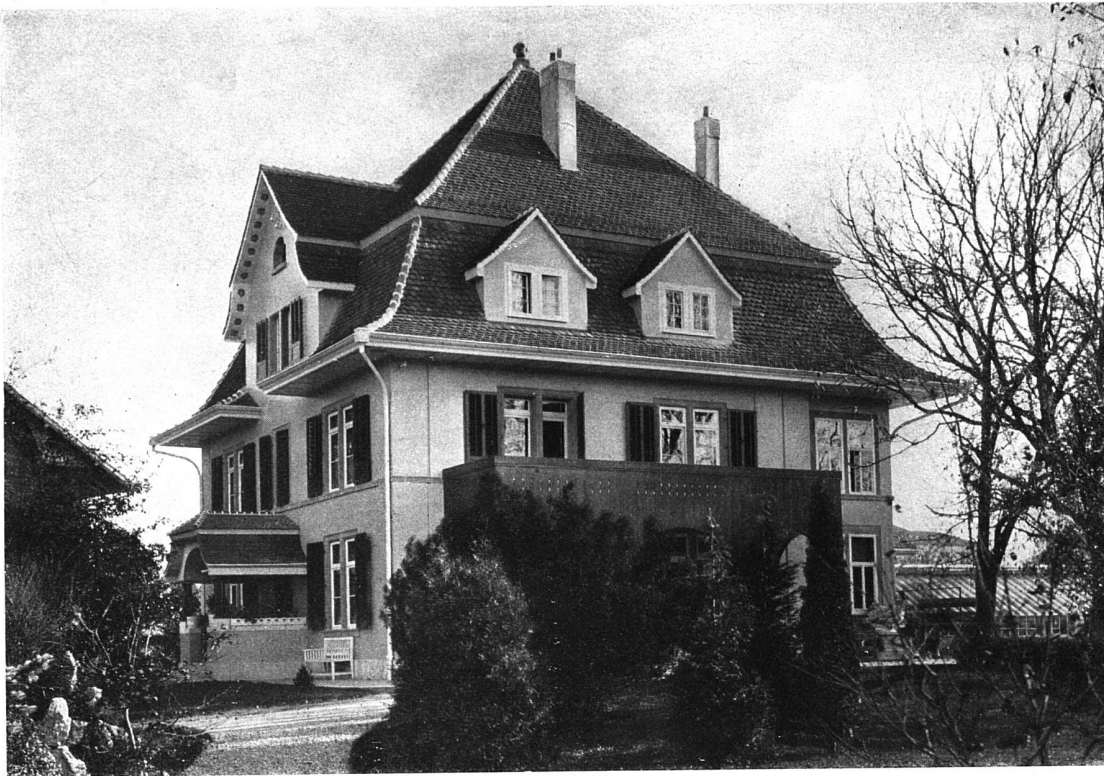
Die Straenfassade nach dem Umbau
