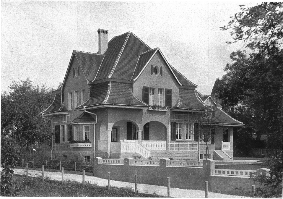
Ansicht der Südfassade
