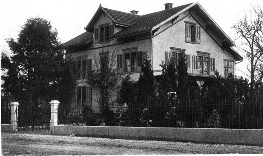
Die StraÙenfassade vor dem Umbau
