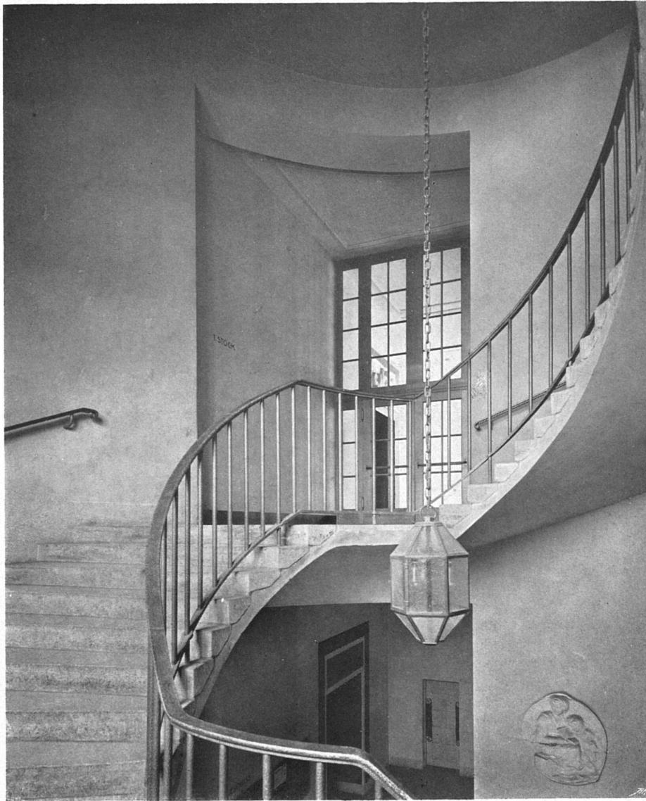
Duale Treppe im Turm Granitstufen auf armiertem Beton
