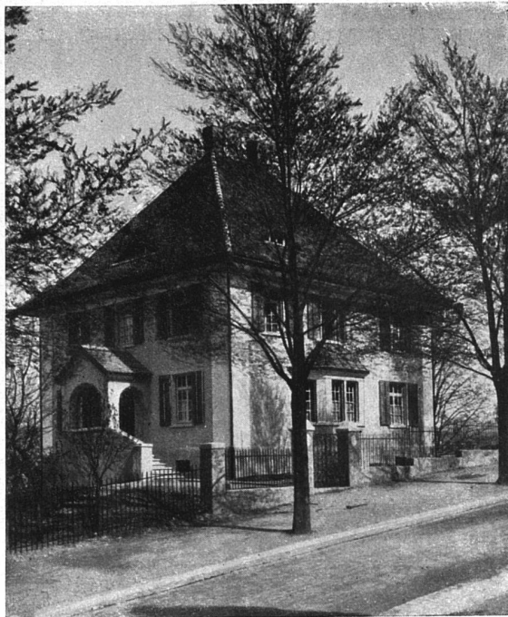
Ansicht von der Straße aus
