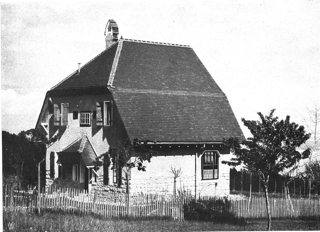
Ein Landhaus in Montmollin (Jura). Architekt (B. S. A.) René Chapallaz in Chaux-de-Fonds
