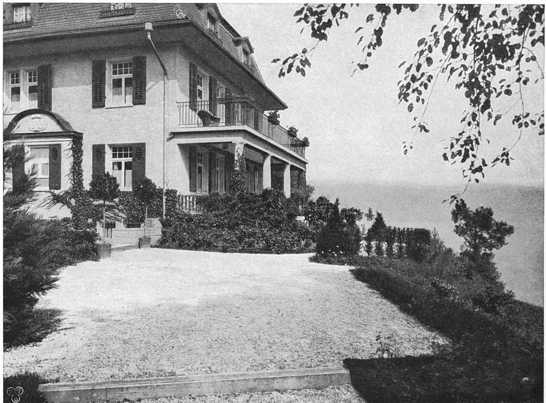
Garten- und Hausterrasse
