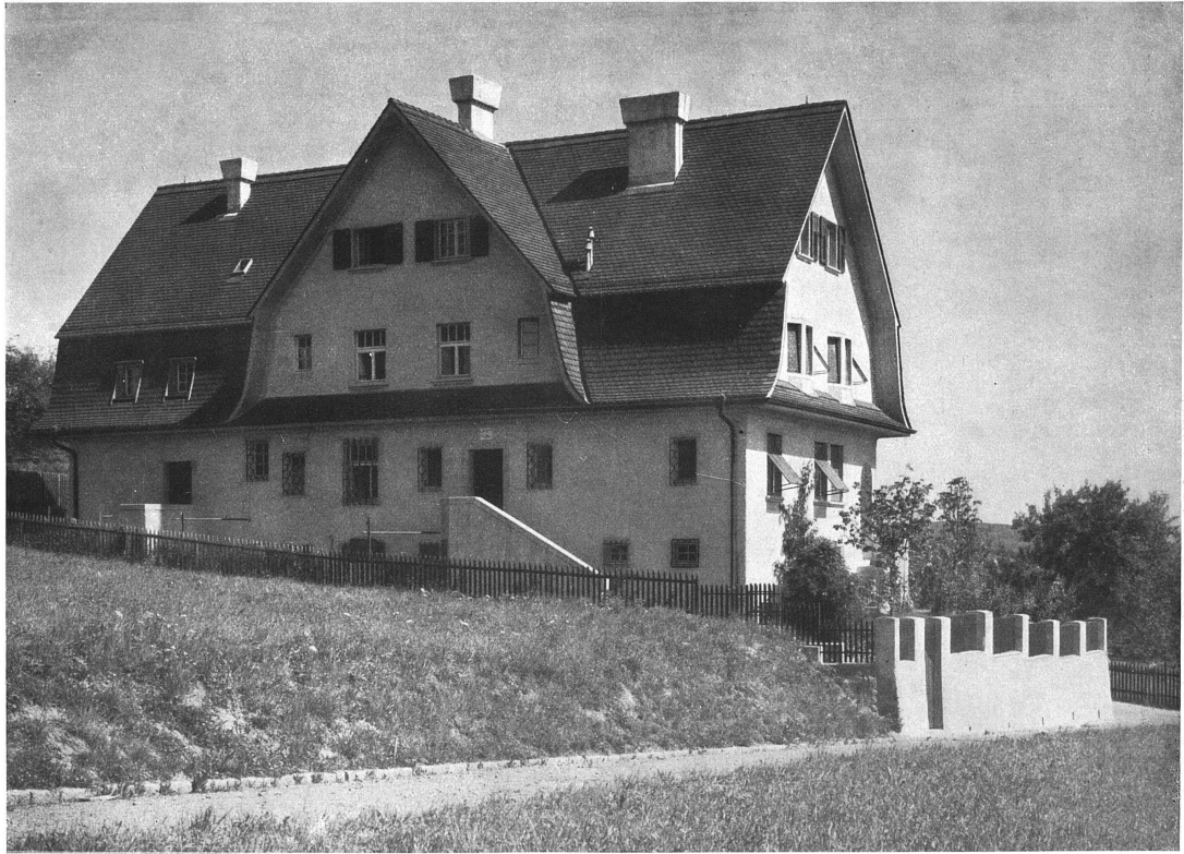
Doppeltwohnhäuser Frey an der Mittelbergstraße in Zürich ::
