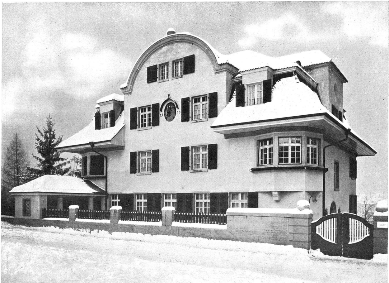
Wohnhaus Kollerweg Nr. 9, Bern Südostfassade :: ::
