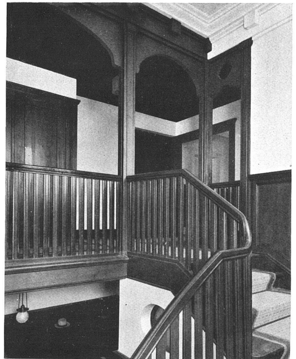
Stoçtreppe mit Abſchluſſ im 1. Stoç
