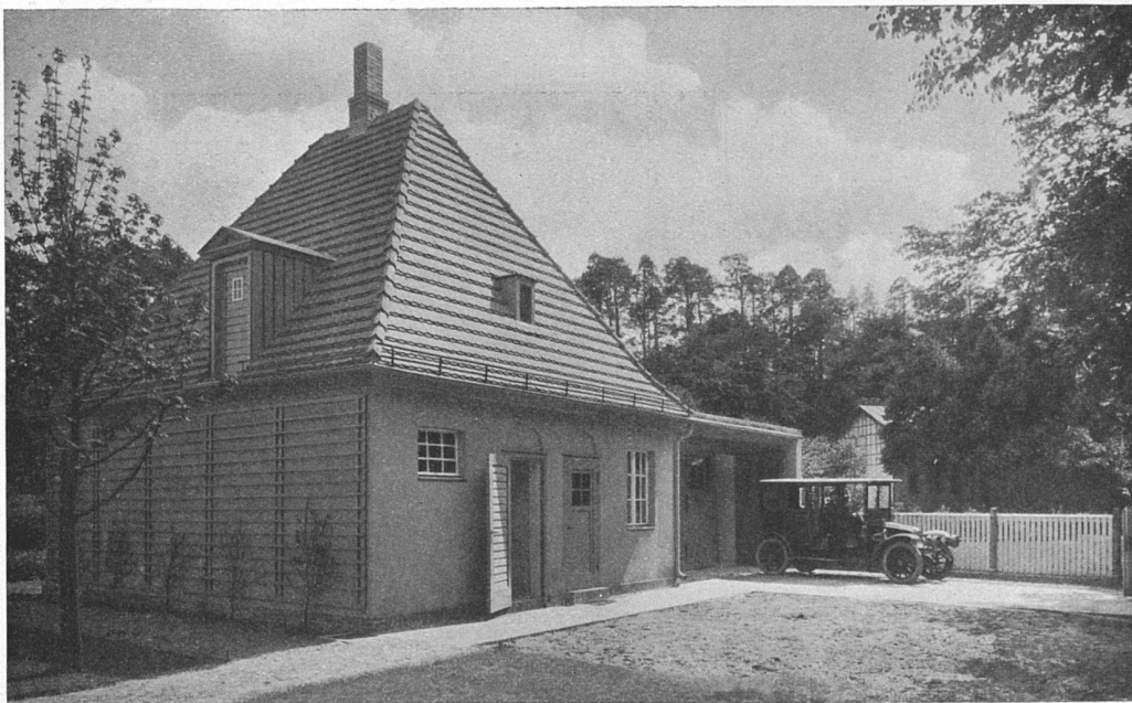
Das Wirtschaftsgebäude mit Garage
