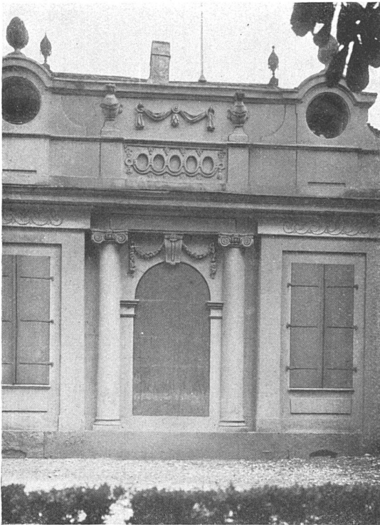
Mittelpartie eines der Seitenpavillons.
