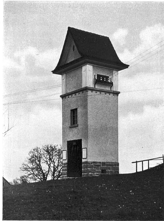
Transformatorhäuschen bei Meggenhusen (Kt. St. Gallen). Ausgeführt vom Kantonsbauamt des Kantons St. Gallen. Aufnahme von E. Hausmann, Heiden.
