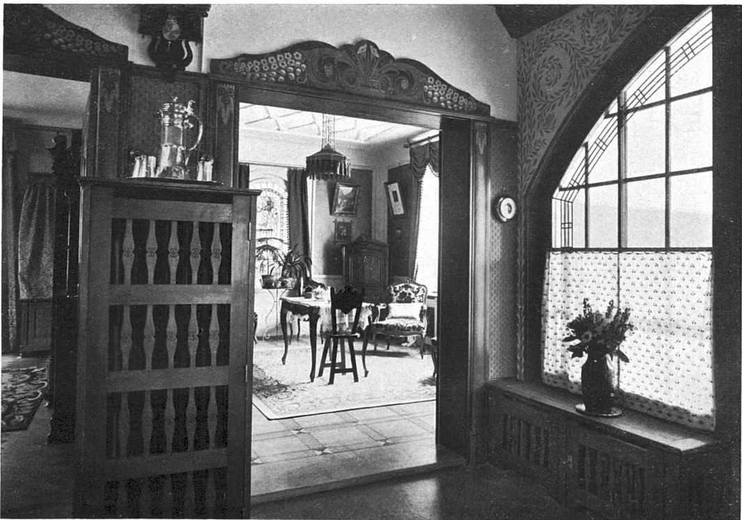
Die Halle der Villa Trauffer-Gempeler zu Interlaken. Architekten Urfer & Stähli, Interlaken.
