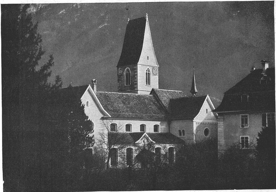
Die Wiederherstellung der Stiftskirche zu Schänis (Kt. St. Gallen). Architekt Adolf Gaudy, Rorschach.
