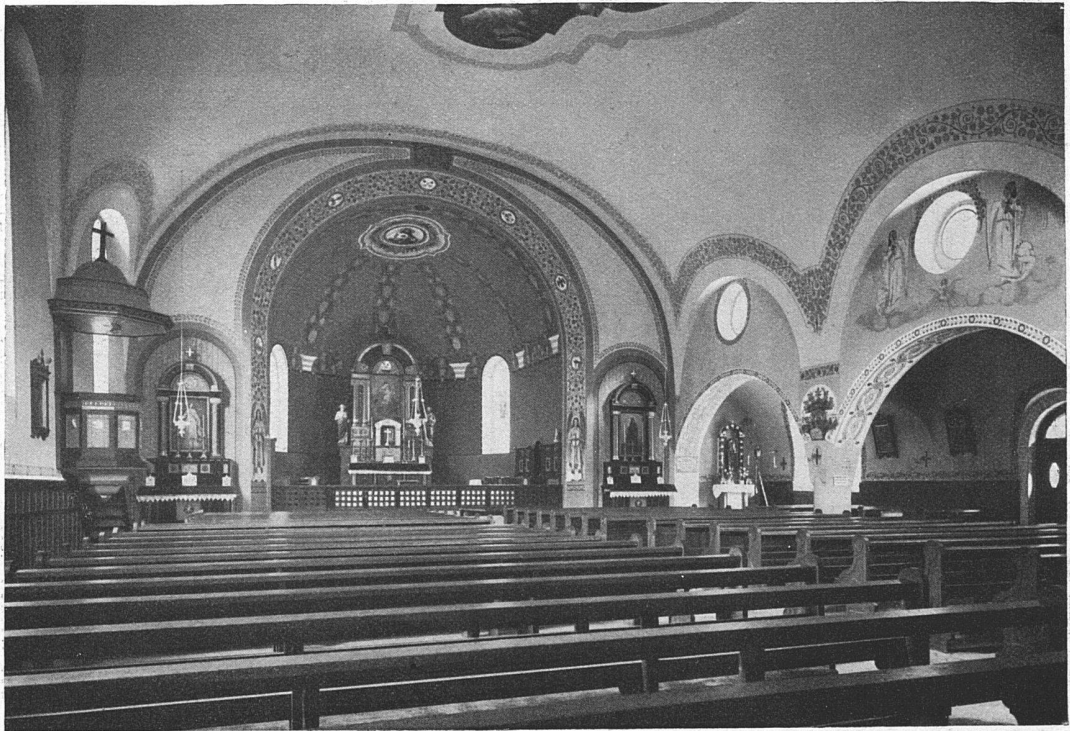
Die katholische Kirche zu Bristen (Kt. Uri). — Südliche Seitenansicht und Inneres. Architekt Adolf Gaudy, Rorschach.
