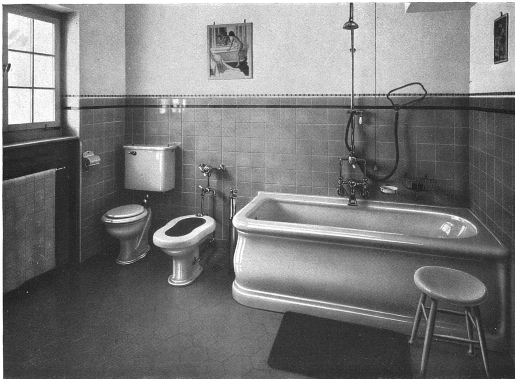
Aus dem Badezimmer einer Villa zu Zürich. — Architekten Marfort & Merkel, Zürich. Sanitäre Einrichtungen von Bamberger, Leroi & Co., Zürich und Frankfurt am Main. Installationen von der Firma Guggenbühl & Müller, Zürich. Aufnahme von A. Wolf-Bender, Zürich.
