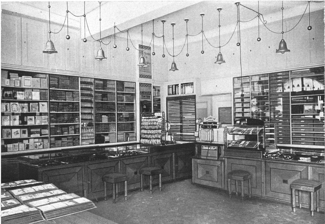
Das Haus zum «Rössli» der Museumsgesellschaft zu St. Gallen. Der Laden der Firma Züllig, Messmer & Co. — Architekten Höllmüller & Hänny, St. Gallen. In Eichen mit schwarzen Einlagen ausgeführt von R. Kunzmann & Co., St. Fiden. Beleuchtungskörper in Alt-Messing von W. Weder & Co., St. Gallen. Aufnahmen von E. Hausamann, Heiden.
