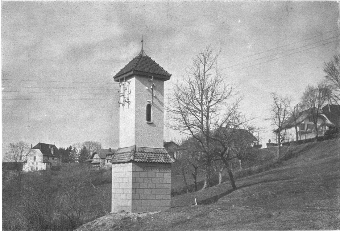
Transformatorhäuschen. Architekten Waeber & Gribi, Bulle.
