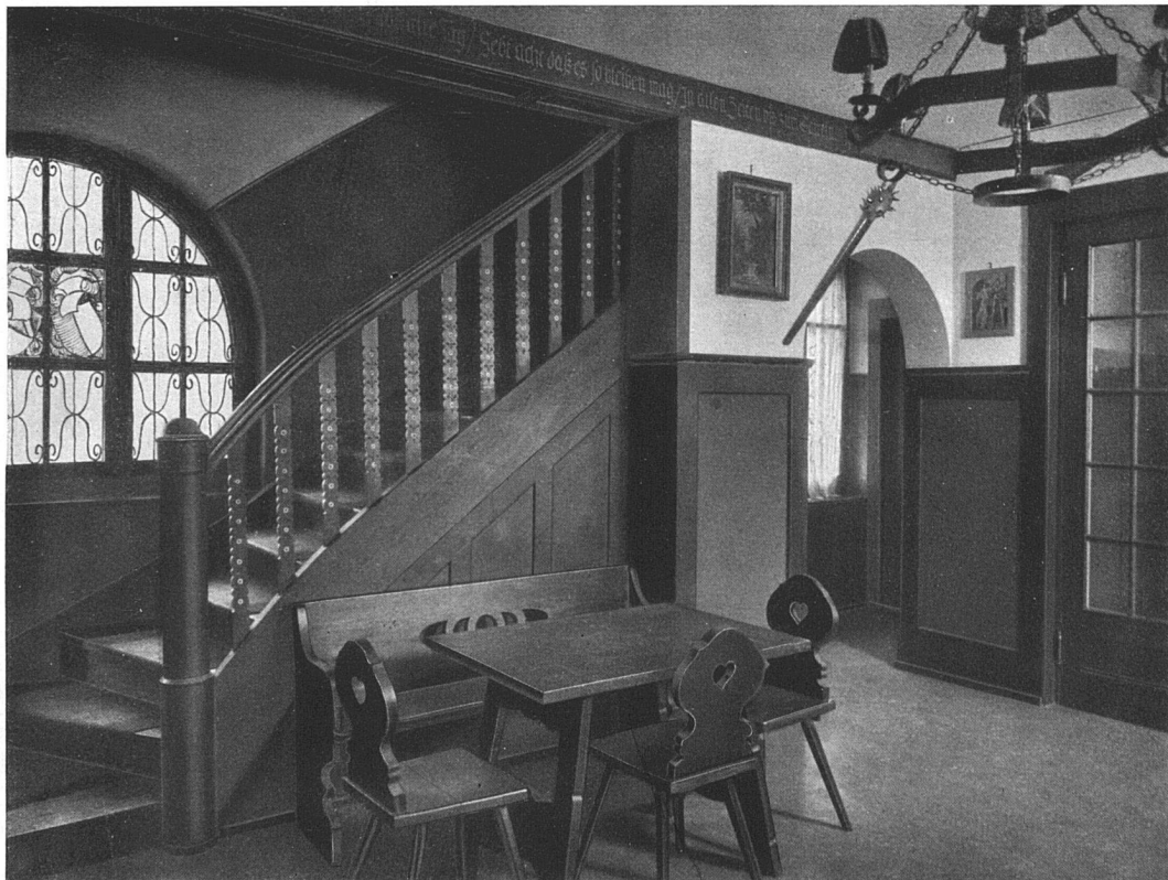
Aus der Halle. — Phot. A. Reinhardt, Sissach. Schreinerarbeiten von Hrn. Rünzi, Sissach; Schlosserarbeiten durch die Eisen- und Stahlwarenfabrik, Sissach. Aus der Villa des Herrn Dr. dent. W. Siegrist in Sissach. Architekten Scherler & Berger, Bern.
