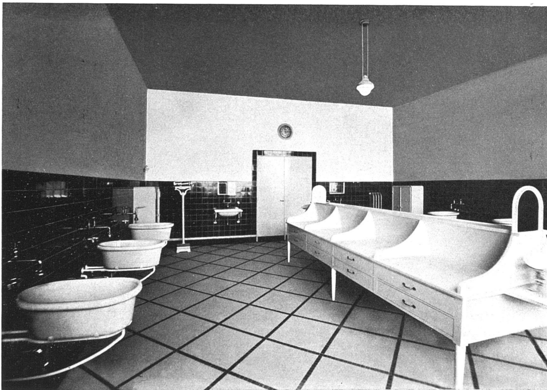
Der Waschraum für Säuglinge im Kinderspital zu Lausanne. — Architekt G. Epitoux, Lausanne.
