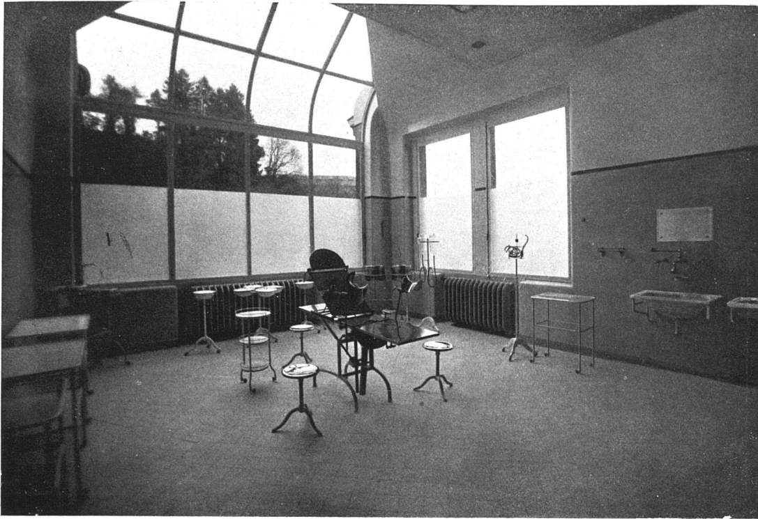
Ein Operationssaal im Frauenspital zu Lausanne. — Architekt G. Epitoux, Lausanne.
