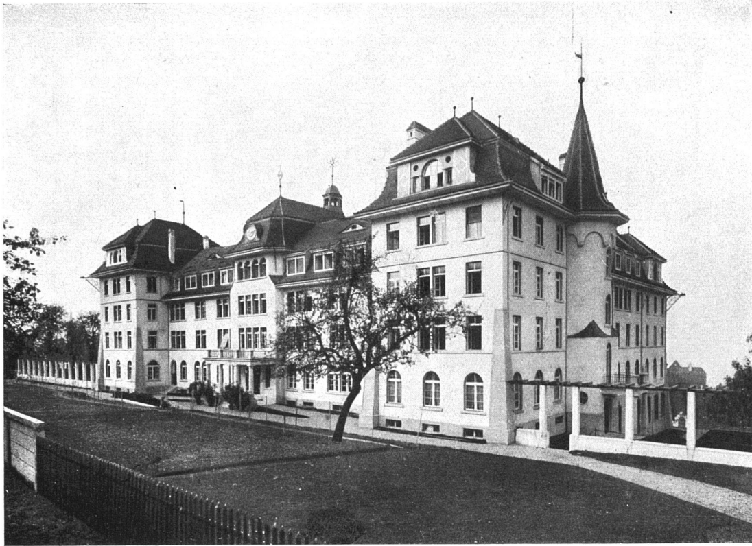
Institut «Stella maris» in Rorschach. — Gesamtansicht. Architekt A. Hardegger, St. Gallen.
