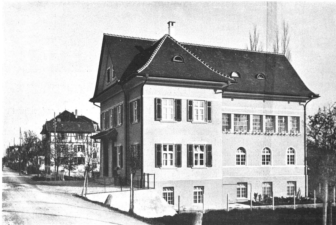
Transformatorengebäude in Arbon. — Ostseite. Architekt A. Kuhn, Arbon.
