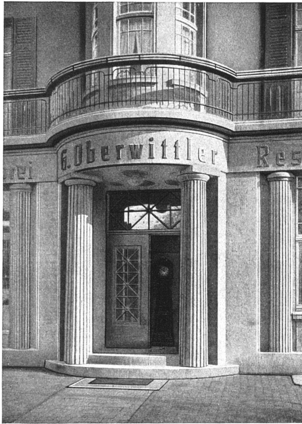
Wohnhaus und Wirtschaftsgebäude Oberwittler in Heepen.
