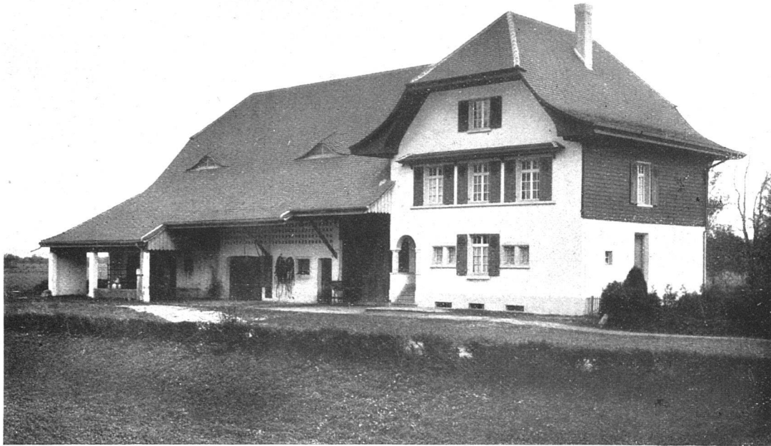
Bauernhaus in Oberbuchsiten (Kanton Solothurn). — Gesamtansicht. Architekt: Eugen Studer, Solothurn.
