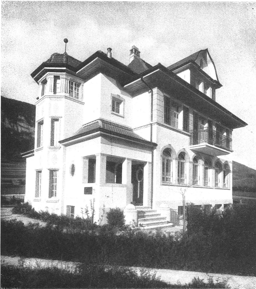
Wohnhaus und Atelier in Crémines bei Münster. — Ansicht von Süden. Architekt: Eugen Studer, Solothurn.
