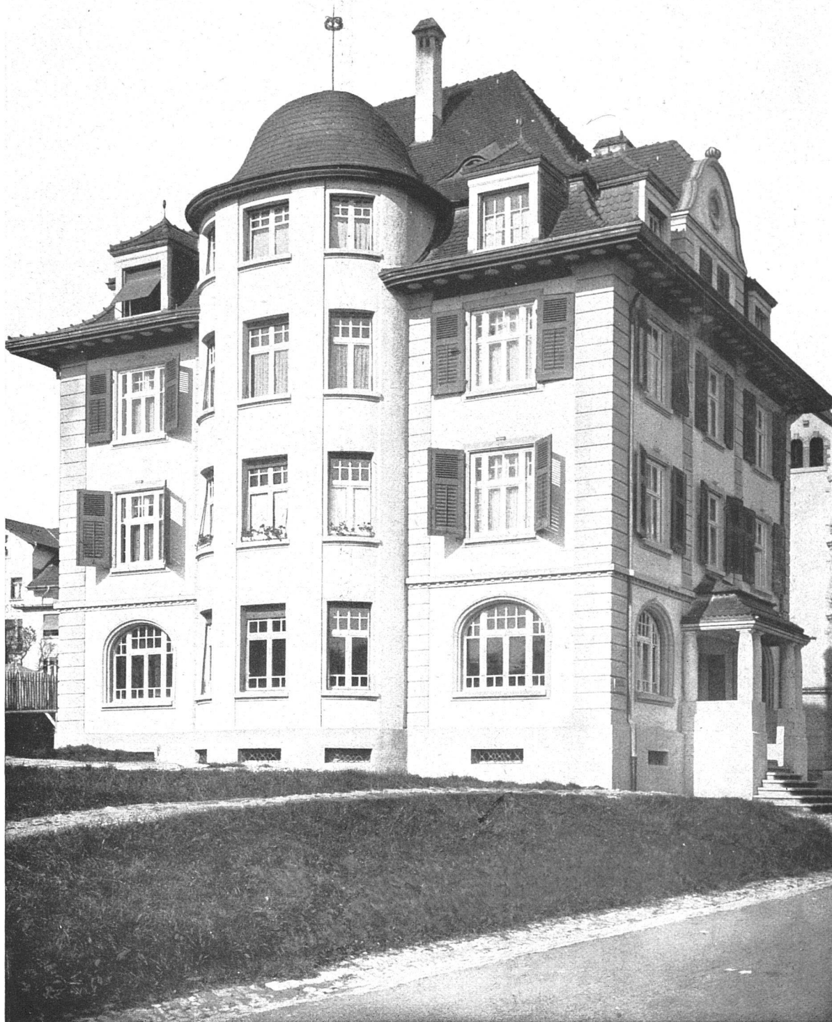
Bürgerhaus in Grenchen. — Gesamtansicht. Architekt: Eugen Studer, Solothurn.
