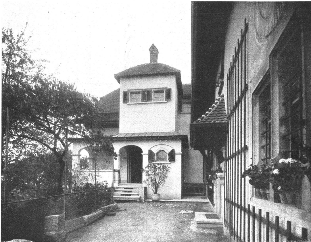
Kaplanei in Oberdorf. — Blick auf den Anbau. — Architekt: Eugen Studer, Solothurn.
