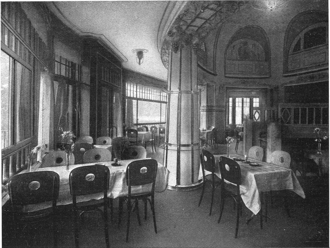
«La Rotonde» in Neuenburg: Blick in das Café. Architekten Rychner & Brandt, Neuenburg.
