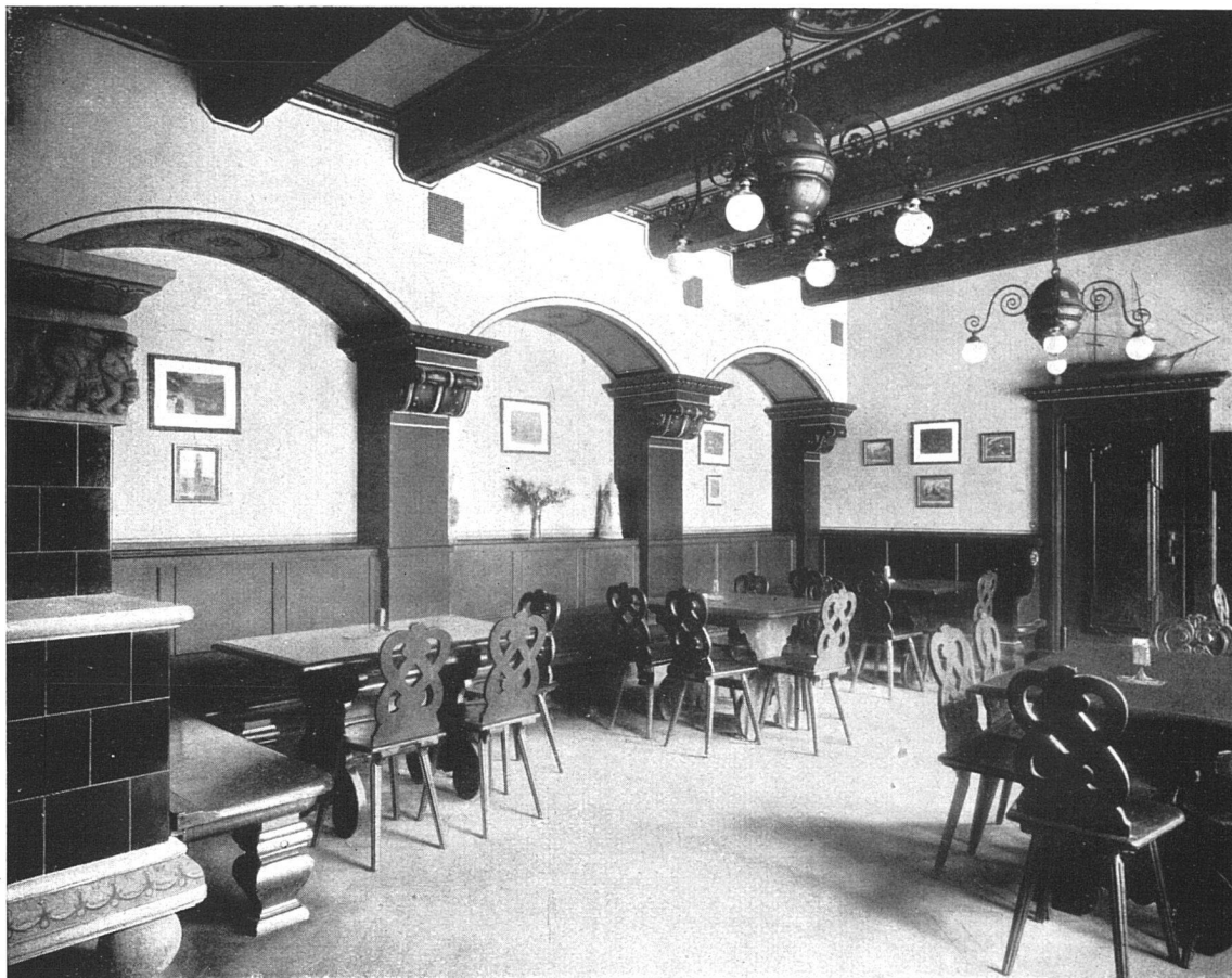
Schützenhaus am Spalenring in Basel. — „Schluch“, Tagesrestaurant. Anbau und Umbau der Architekten: Widmer, Erlacher und Calini, Basel. Phot. A. Teichmann, Basel.
