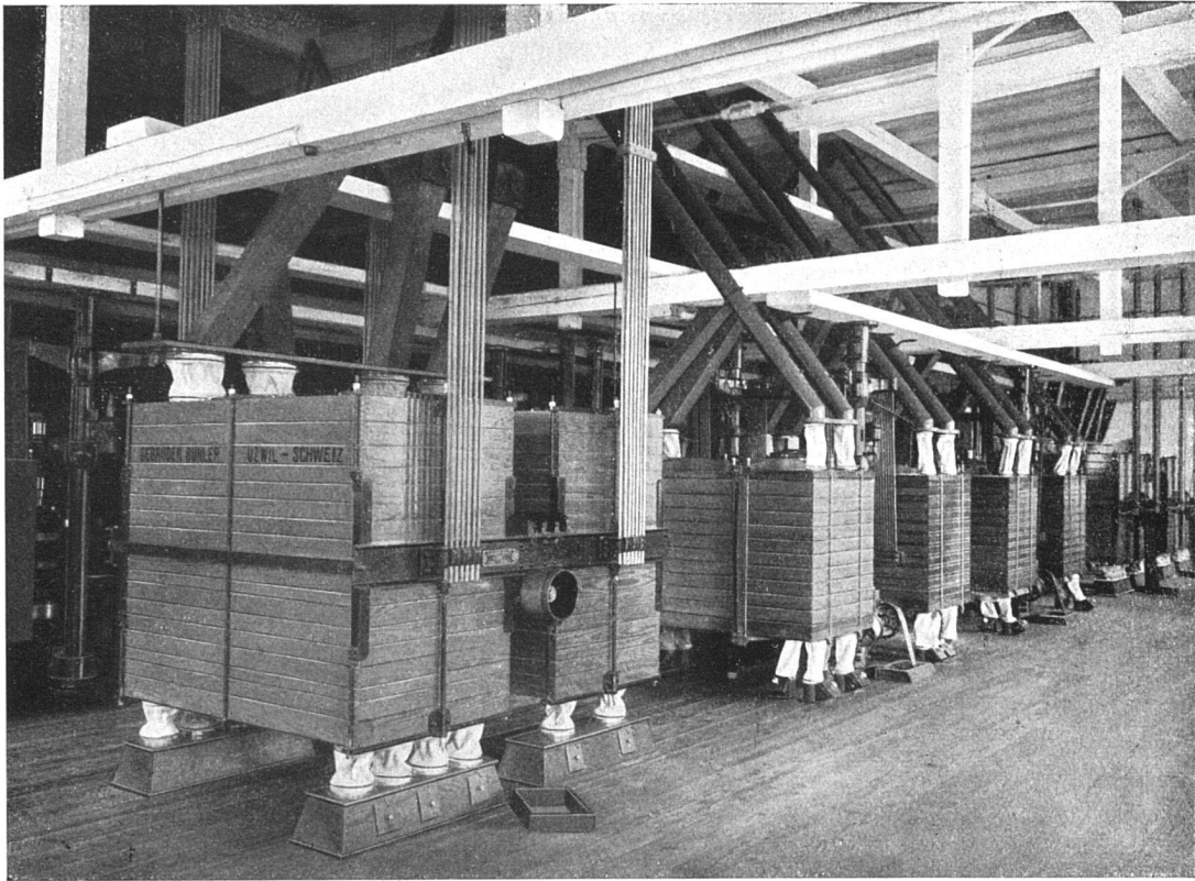
Mühlennubau der Firma Steiners Söhne in Malters. — III. Stock: Plansichterboden. Architekt: Johann Bucher, Luzern.
