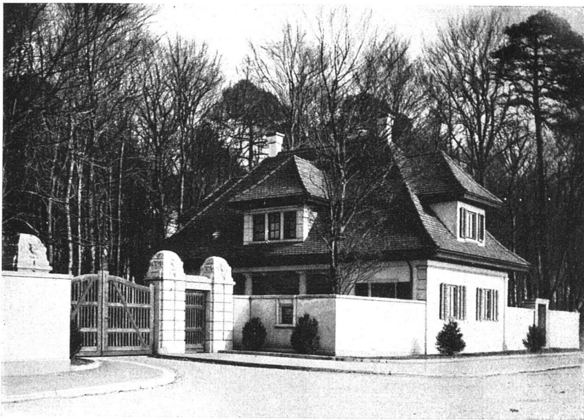
Waldfriedhof in Schaffhausen. — Pförtnerhaus.
