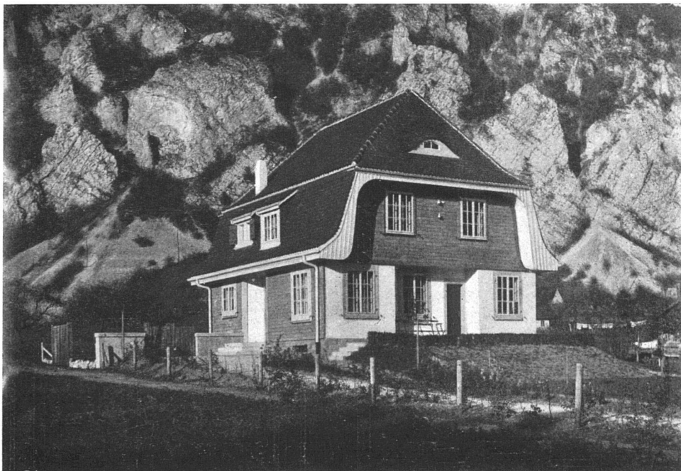
Wohnhaus E. Walter in Balsthal. — Südwestseite. Architekten von Arx & Real, Olten.
