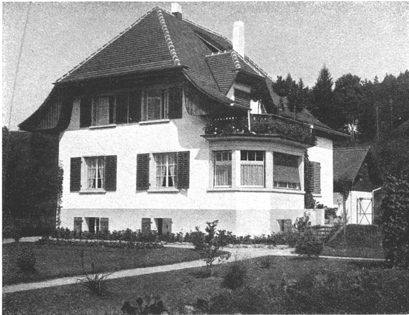
Landhaus Lüscher in Teufenthal. — Ansicht von Süden. Architekten von Arx & Real, Olten.
