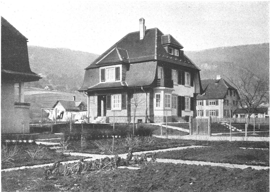
Wohnhaus von Ing. W. Haerberli-Walter in Balsthal. — Südwestseite. Architekten von Arx & Real, Olten.
