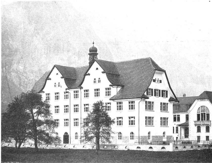
Schulhaus in Erstfeld. — Rückansicht. Meili-Wapf & Armin Meili, Architekten, Luzern.
