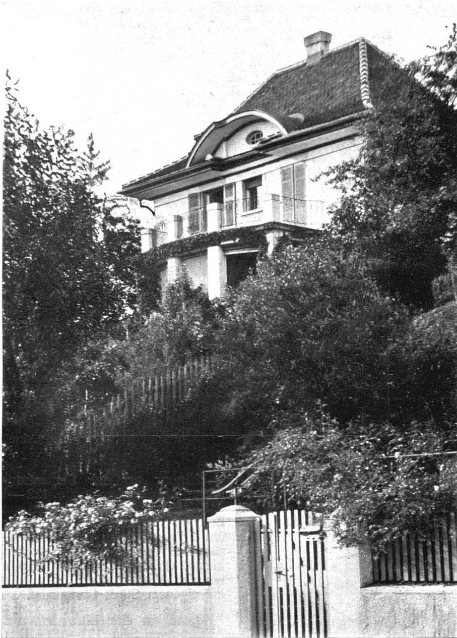
Haus an der Susenbergstrasse in Zürich. — Ansicht von der Strasse.
