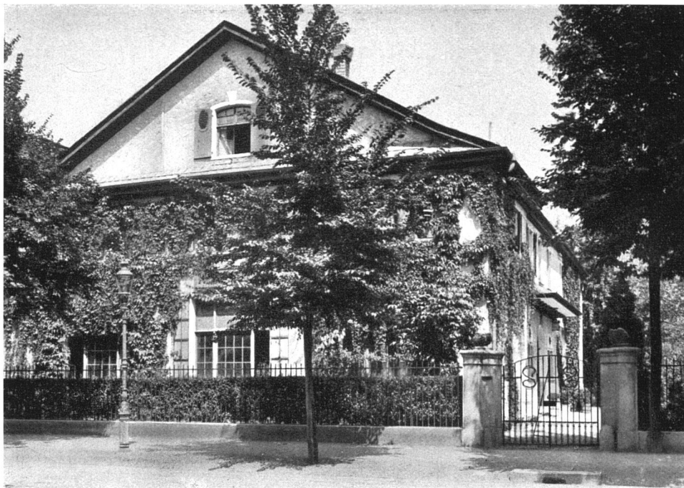
Laboratorium M. U. Schoop in Zürich. Architekt: A. Cristofari, Zürich.
