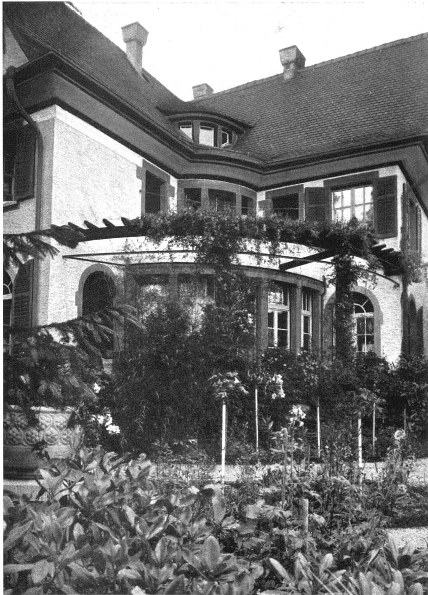
Villa an der Hochstrasse in Zürich. — Südseite.
