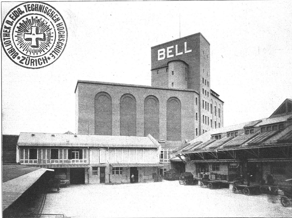
Das Kühlhaus der Bell A.-G. zu Basel. — Ansicht vom Hofe.
