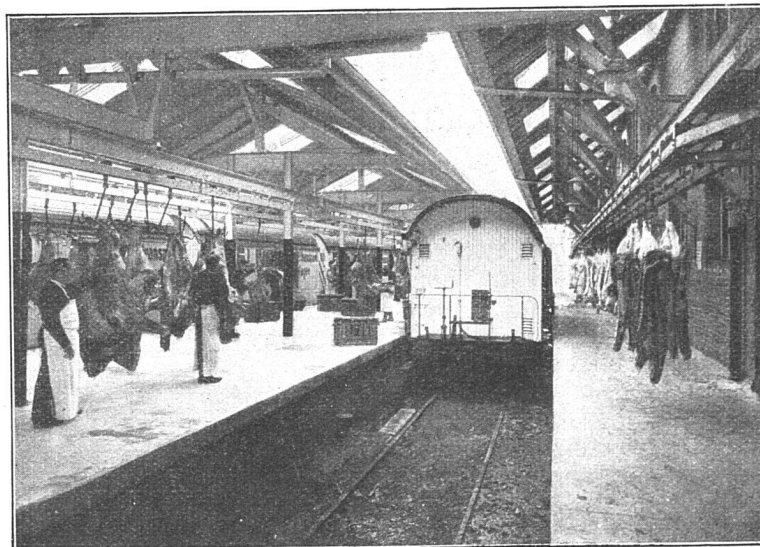
Das Kühlhaus der Bell A.-G. zu Basel.
