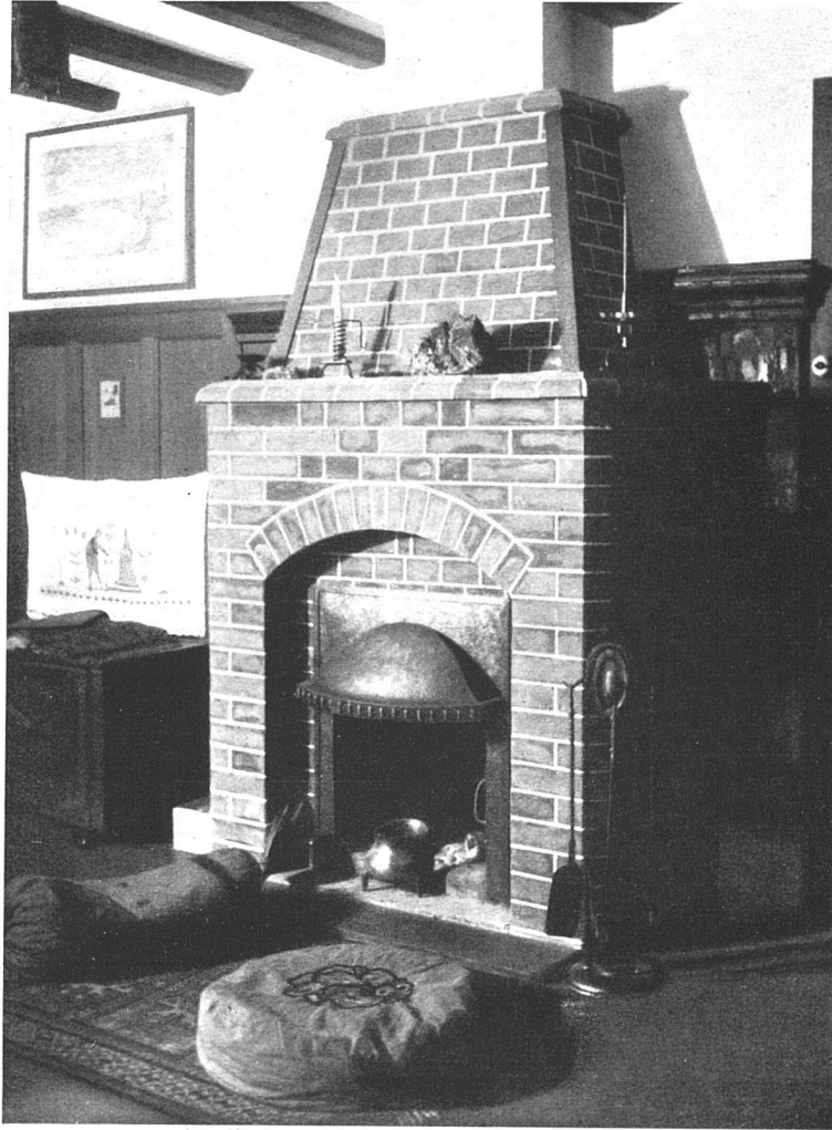
Chalet „Signina“, Flims — Cheminée im Wohnzimmer — Erdgeschoss Architekt J. Nold, Felsberg
