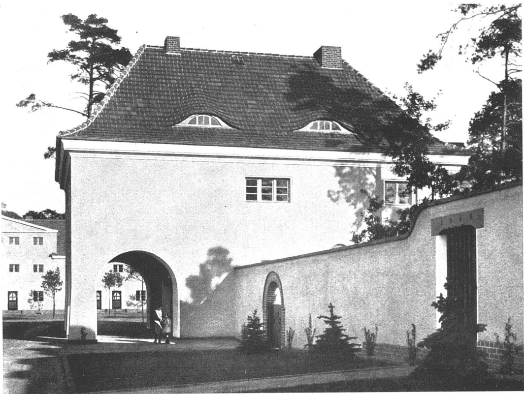
Siedlung Cöpenick — Kopfbauten mit Läden Architekt O. R. Salvisberg, Berlin
