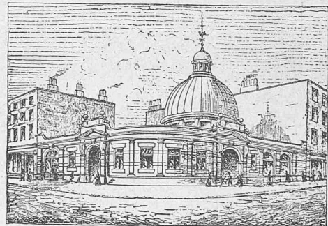
Empfangsgebäude der Station Borough-High-Street.
