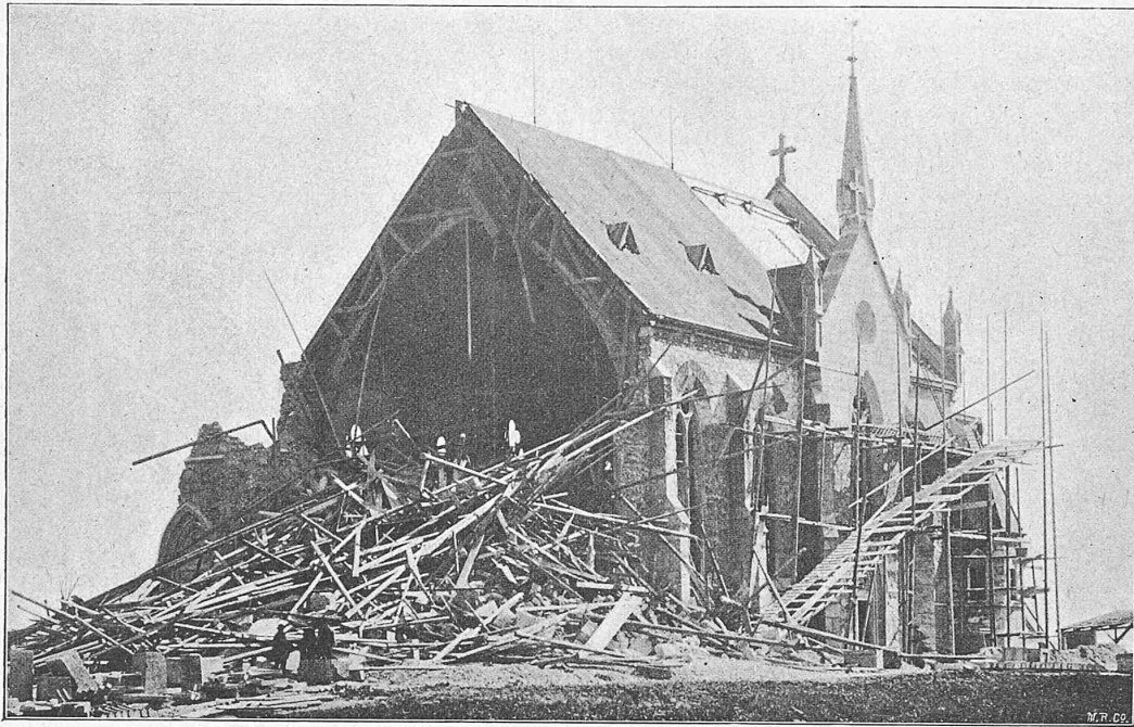
Ansicht der Kirche nach dem Einsturz des Turmes.
