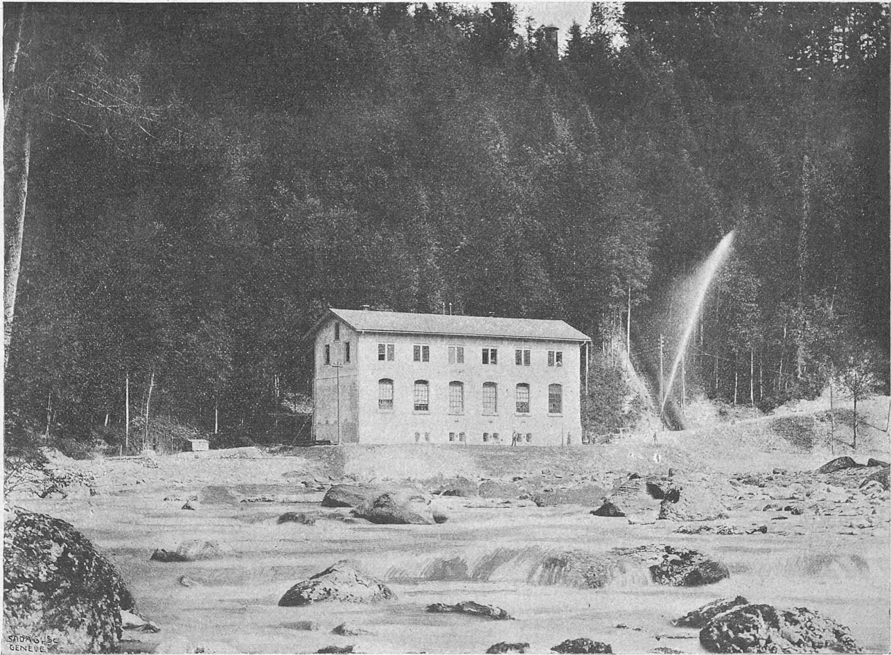
Fig. 31. Ansicht des Maschinenhauses (Auf der Höhe: der Luftschacht der Rohrleitung).
