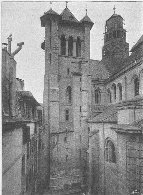
Tour du Nord; face ouest avant la restauration (1889).
