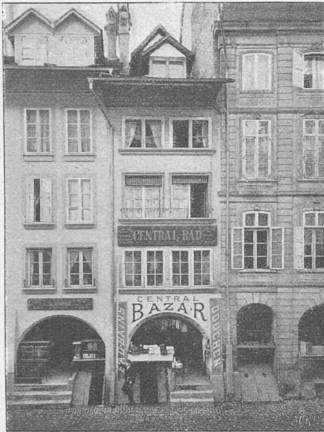
Objekt III, Marktgasse 43. (Photogr. von F. Rohr in Bern.)
