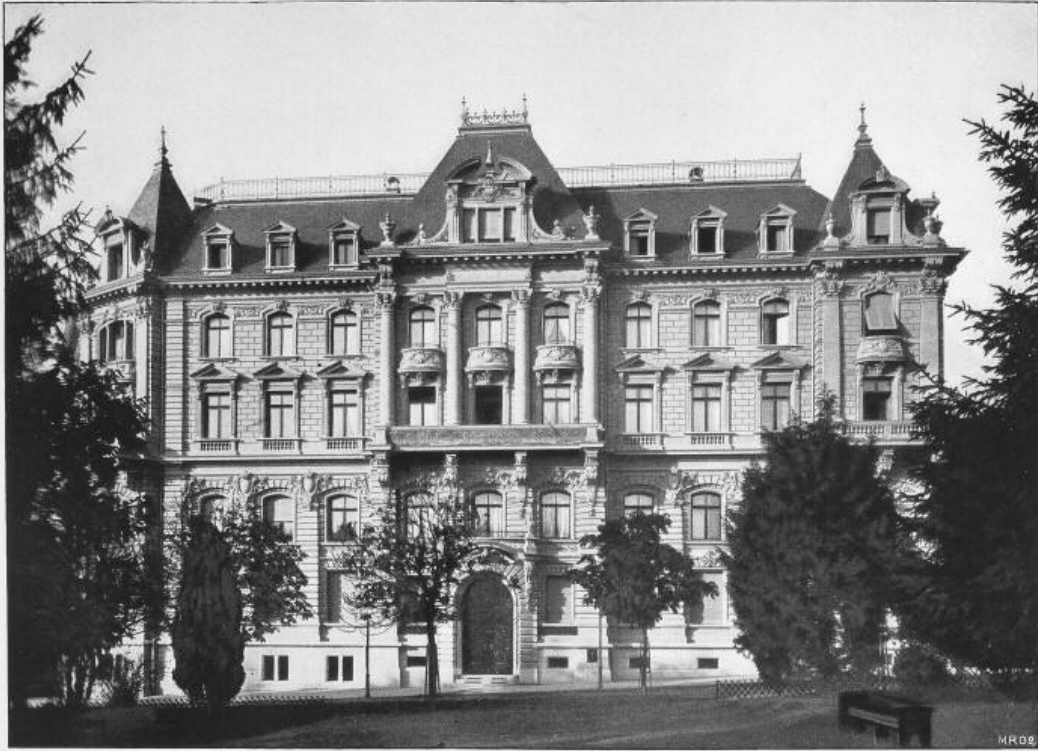
Verwaltungsgebäude der Schweizerischen Mobiliar-Versicherungs-Gesellschaft in Bern.
