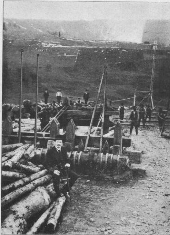
Fig. 7. Abladestelle mit Spannvorrichtung auf Bellen.
