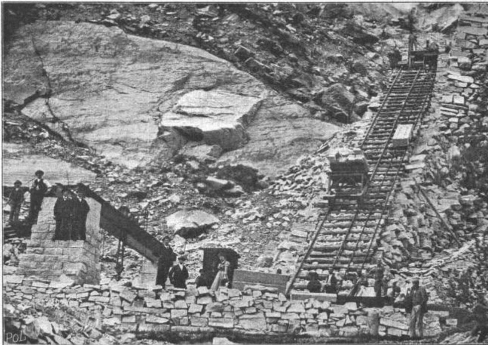
Bremsberganlage im Tessin für Granitsteine, mit seitlich angeordnetem Krahn.
