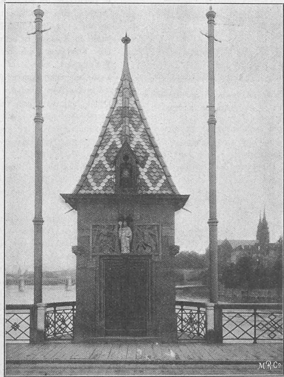
Vorderansicht der Kapelle auf der mittleren Rheinbrücke in Basel.
