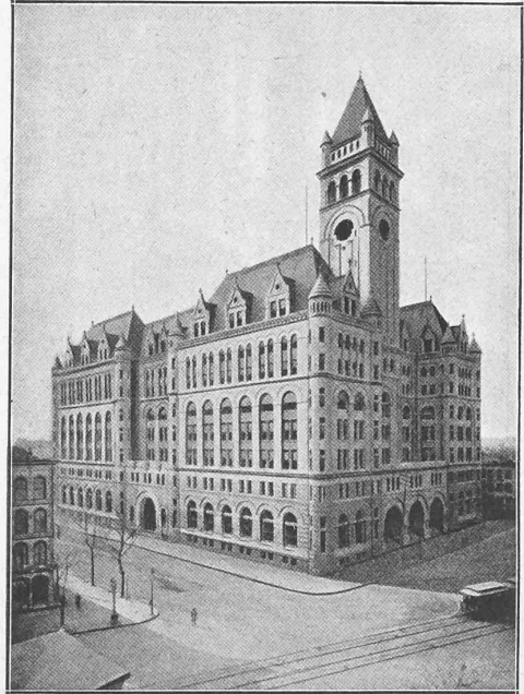
Abb. 36. Washington. — Das Postgebäude.
