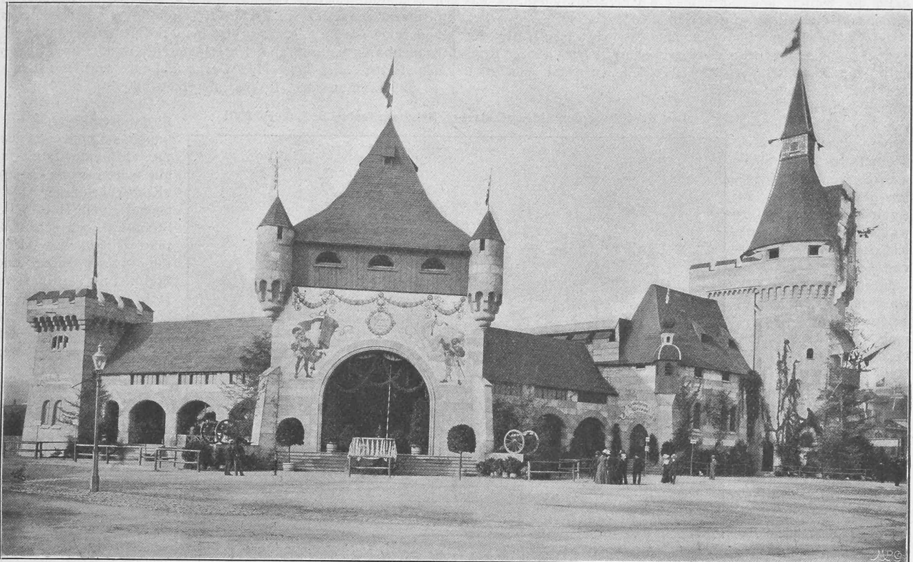
Abb. 3. Fassade der Festhütte. — Gabentempel und Empfangshalle.
