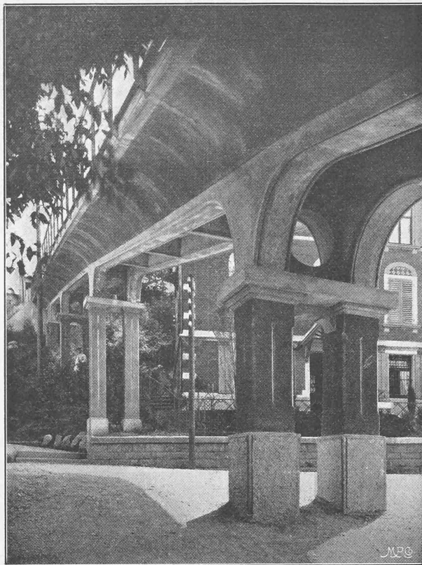
Abb. 8. Die Hadlaubbrücke. — Unterführung der Hadlaubstrasse.
