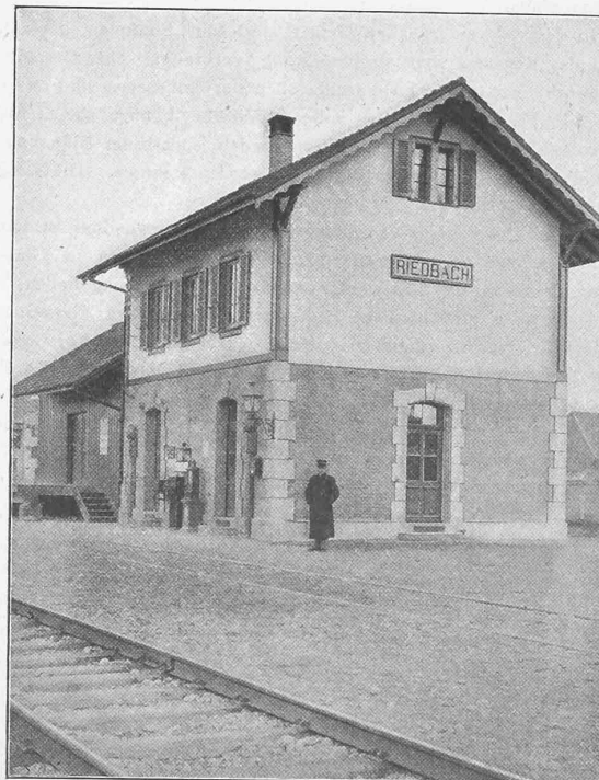
Abb. 13. Ansicht eines normalen Stationsgebäudes.
