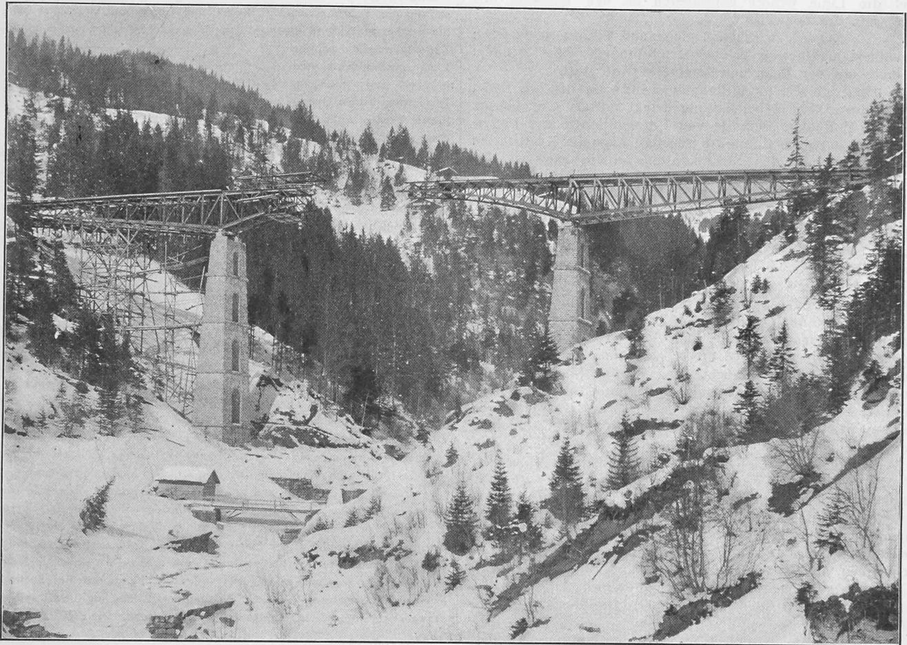
Abb. 3. Obere Adhäsionsstrecke der Bex-Gryon-Villars-Bahn. — Cantilever-Fachwerkbrücke über die Gryonne. Erbaut von den Ateliers de constructions mécaniques in Vevey.
