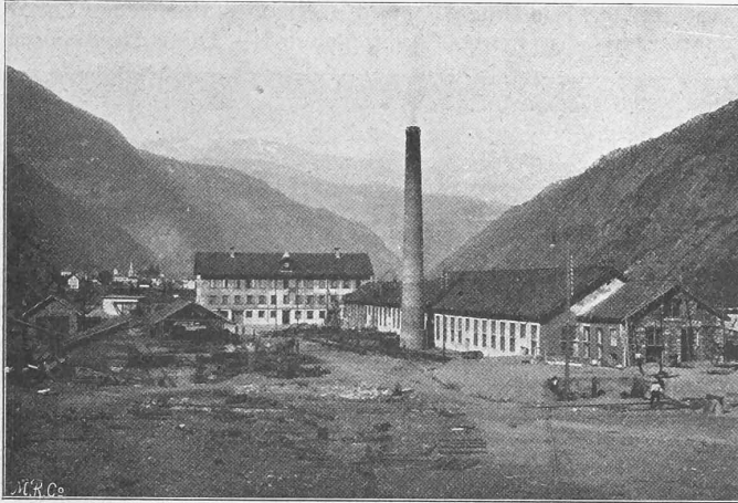
Abb. 44. Installationsplatz der Nordseite. — Maschinenhaus und Bureaux.
