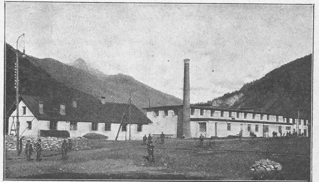
Abb. 45. Nordseite. — Stationsgebäude beim Tunnelleingang.
