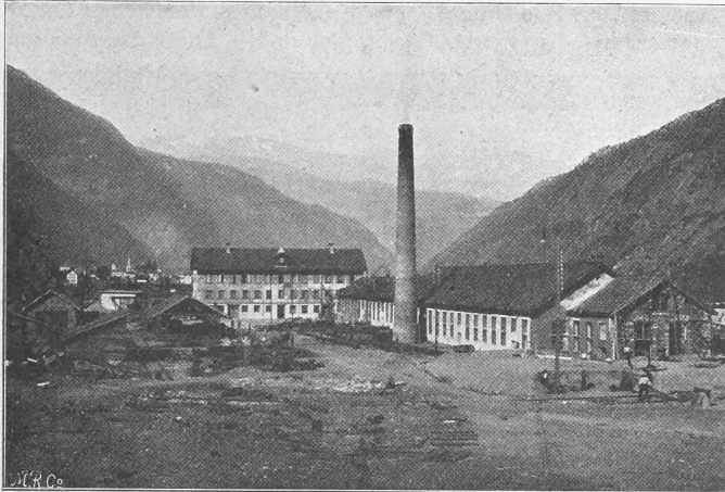
Abb. 44. Installationsplatz der Nordseite. — Maschinenhaus und Bureaux.
