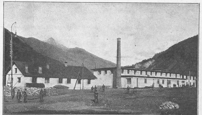
Abb. 45. Nordseite. — Stationsgebäude beim Tunnelleingang.
