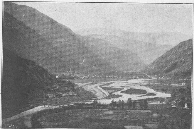
Abb. 41. Nordseite. — Ansicht des Installationsplatzes von Osten.
