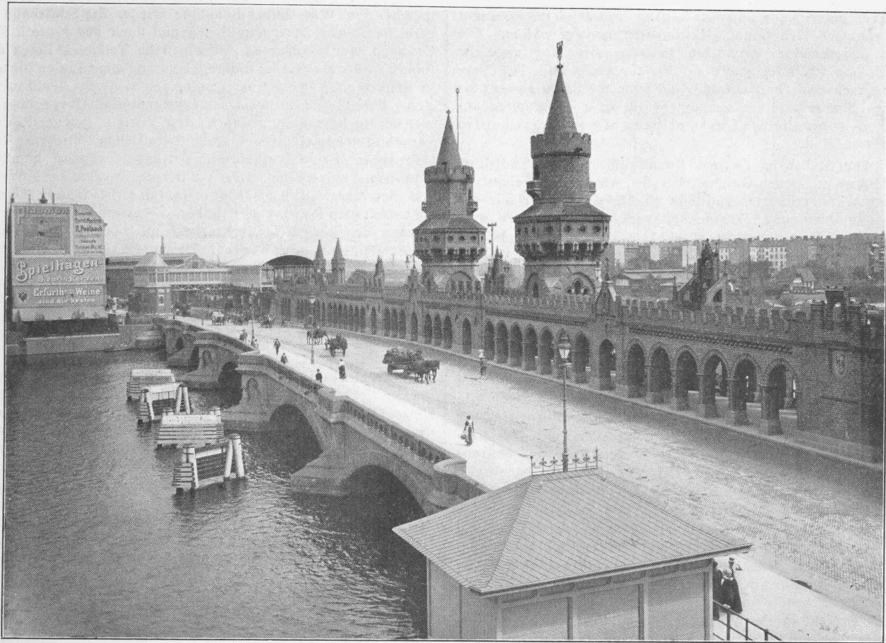
Abb. 2. Die Oberbaumbrücke mit dem Viadukt der Hochbahn.
